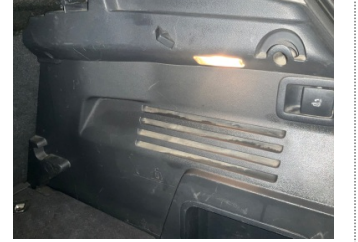
Döşemeler/Kapaklar, Döşemeler/Kapaklar > Çizik
