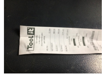
Elektrik donanımı/Pano, Akü > Test Sonucu
