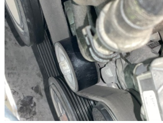
Motorsoğutması, Kayış > Çatlak
