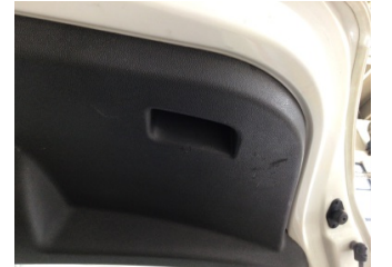
Döşemeler/Kapaklar, Bagaj kapağı, iç döşemesi > Çizik
