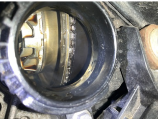
Motor, Triger kayışı > Çatlak
