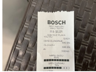
Elektrik donanımı/Pano, Akü > Test Sonucu
