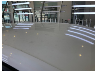
Tavan, Tavan > Dolu Hasarı
