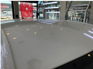
Tavan, Tavan > Dolu Hasarı
