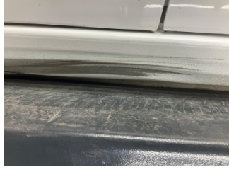
Marşbiyel, sağ, Marşbiyel, sağ > Hasarlı
