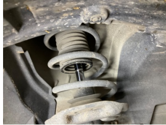
Ön aks, Amortisör körüğü, sağ > Hasarlı
