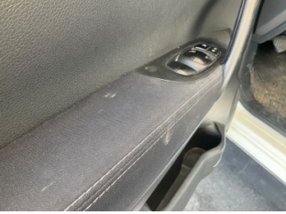
Döşemeler/Kapaklar, Döşemeler/Kapaklar > Deforme Olmuş
