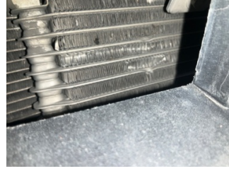
Motor, Yağ soğutucusu > Hasarlı
