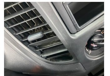
Kalorifer/Klima, Havalandırma ızgarası sabitlemesi > Hasarlı
