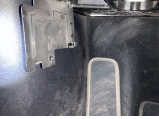
Döşemeler/Kapaklar, Döşemeler/Kapaklar > Kırılmış
