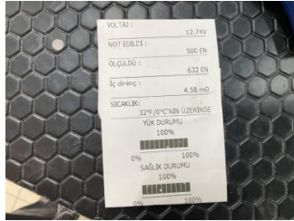
Elektrik donanımı/Pano, Akü > Test Sonucu
