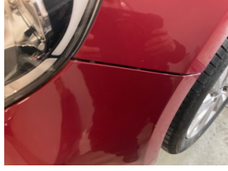
Tampon, ön, Ön tampon > Sabitlemesi Hatalı
