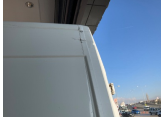
Kaporta, D-direk, sol > Hasarlı
