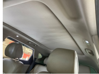
Döşemeler/Kapaklar, Döşemeler/Kapaklar > Kirlenmiş
