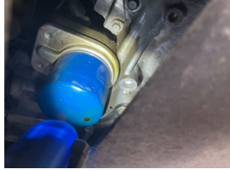
Motor, Yağ soğutucusu > Yağ Kaçağı
