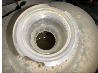
Motorsoğutması, Soğutma sıvısı > Kirlenmiş
