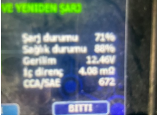
Elektrik donanımı/Pano, Akü > Test Sonucu
