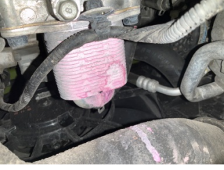
Motorsoğutması, Soğutma sıvısı > Sızdırıyor
