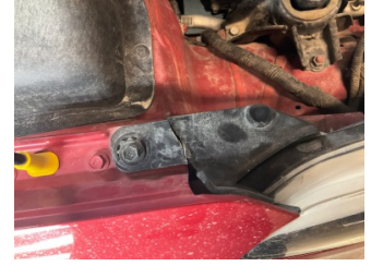
Farlar, Far bağlantı ayağı, sağ > Hasarlı
