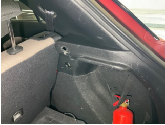
Döşemeler/Kapaklar, Pandizot > Kırılmış
