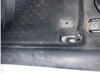
Döşemeler/Kapaklar, Döşemeler/Kapaklar > Yakıcı Madde ile Zarar Görmüş
