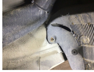
Çamurluk, sol arka, Davlumbaz > Kırılmış
