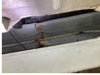
Tampon, arka, Bağlantı ayağı > Hasarlı
