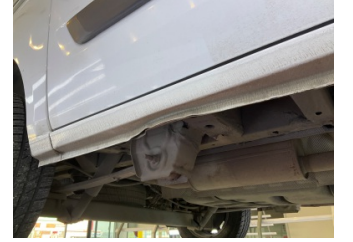
Marşbiyel, sağ, Marşbiyel, sağ > Hasarlı
