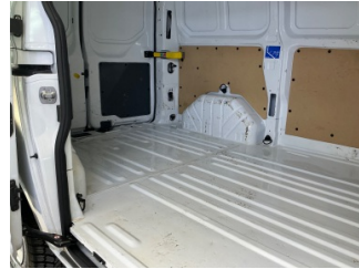
Döşemeler/Kapaklar, Döşemeler/Kapaklar > Deforme Olmuş
