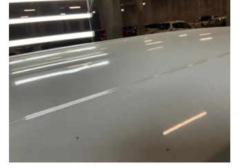
Tavan, Tavan > Dolu Hasarı
