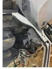
Döşemeler/Kapaklar, Döşemeler/Kapaklar > Deforme Olmuş
