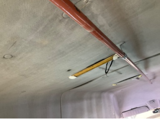
Döşemeler/Kapaklar, Tavan döşemesi > Standart Dışı Onarım
