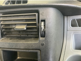
Kalorifer/Klima, Havalandırma izgarası sabitlemesi > Hasarlı
