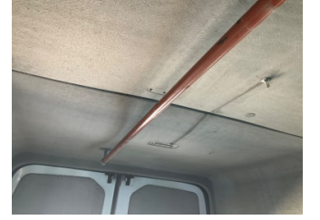
Döşemeler/Kapaklar, Tavan döşemesi > Standart Dışı Onarım
