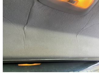
Döşemeler/Kapaklar, Tavan döşemesi > Deforme Olmuş
