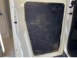
Döşemeler/Kapaklar, Döşemeler/Kapaklar > Deforme Olmuş
