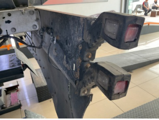
Elektrik donanımı/Pano, Kablo demeti > Standart Dışı Onarım
