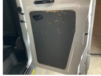
Döşemeler/Kapaklar, Döşemeler/Kapaklar > Hasarlı
