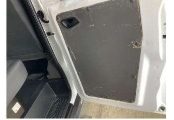
Döşemeler/Kapaklar, Döşemeler/Kapaklar > Deforme Olmuş
