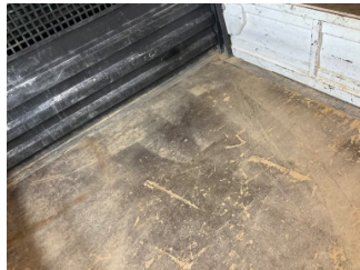
Döşemeler/Kapaklar, Bagaj kapağı, iç döşemesi > Boyası Atmış
