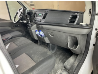
Döşemeler/Kapaklar, Döşemeler/Kapaklar > Kirlenmiş
