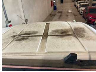
Tavan, Tavan > Hasarlı
