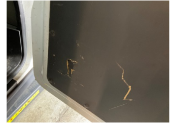
Döşemeler/Kapaklar, Döşemeler/Kapaklar > Hasarlı
