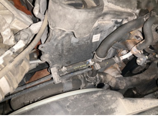
Motorsoğutması, Soğutma sıvısı > Sızdırıyor
