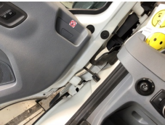
Kapı, sol ön, Kapı gergisi > Ses Yapıyor
