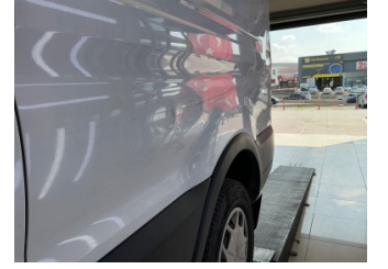
Çamurluk, sol arka, Çamurluk, sol arka > Hasarlı
