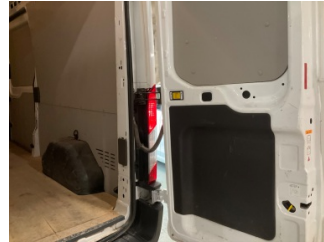
Döşemeler/Kapaklar, Döşemeler/Kapaklar > Çizik
