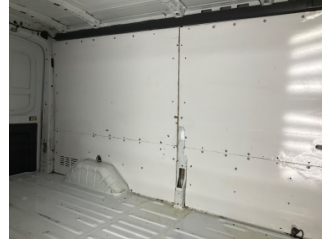
Döşemeler/Kapaklar, Döşemeler/Kapaklar > Deforme Olmuş
