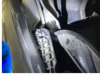
Farlar, Far bağlantı ayağı, sağ > Sabitlemesi Hatalı
