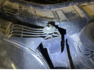
Farlar, Far bağlantı ayağı, sağ > Sabitlemesi Hatalı
