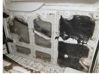
Döşemeler/Kapaklar, Döşemeler/Kapaklar > Sökülmüş-Yok
