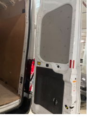
Döşemeler/Kapaklar, Döşemeler/Kapaklar > Hasarlı
