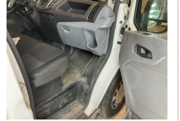
Döşemeler/Kapaklar, Döşemeler/Kapaklar > Çizik
