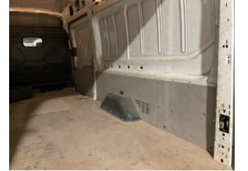
Döşemeler/Kapaklar, Döşemeler/Kapaklar > Kirlenmiş
