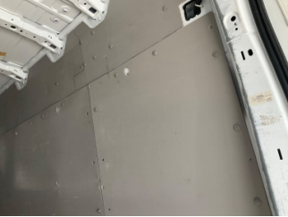
Döşemeler/Kapaklar, Bagaj bölümü döşemesi > Hasarlı
