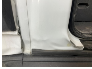
Kaporta, B-direk, sağ > Hasarlı
