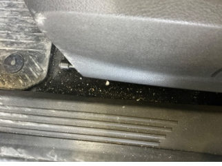
Döşemeler/Kapaklar, Döşemeler/Kapaklar > Yakıcı Madde ile Zarar Görmüş
