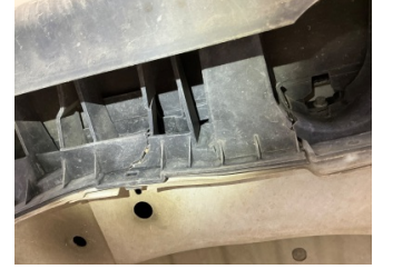
Tampon, arka, Bağlantı ayağı > Hasarlı
