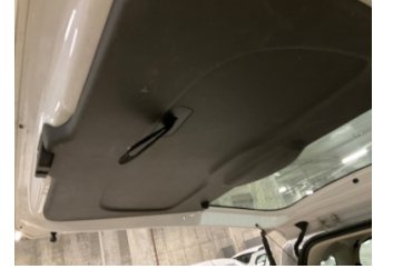
Döşemeler/Kapaklar, Döşemeler/Kapaklar > Çizik
