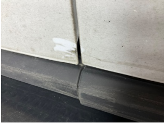
Kapı, sağ arka, Kapı, sağ arka > Çizik
