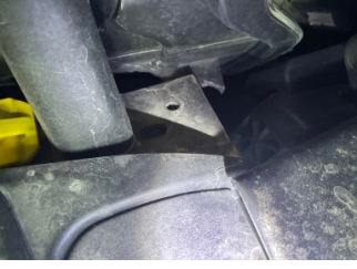
Farlar, Far bağlantı ayağı, sol > Hasarlı
