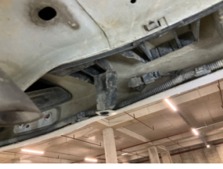
Tampon, arka, Bağlantı ayağı > Hasarlı
