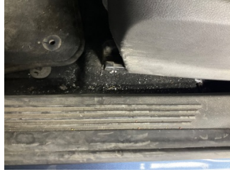
Döşemeler/Kapaklar, Döşemeler/Kapaklar > Yakıcı Madde Ile Zarar Görmüş
