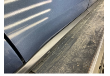
Kapı, sağ arka, Kapı, sağ arka > Ezik
